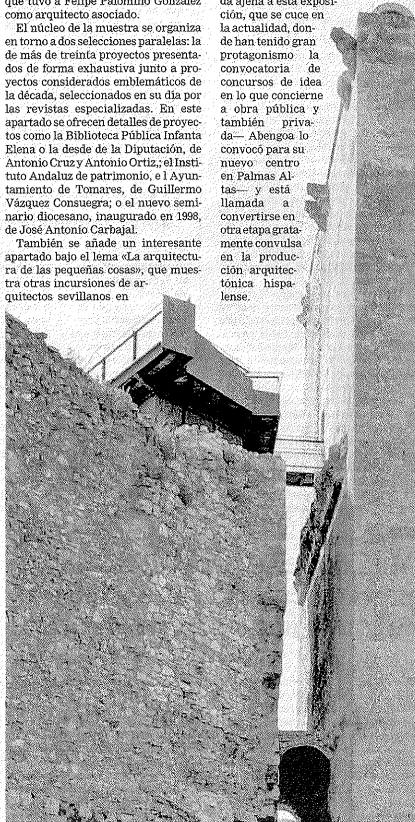
Rehabilitación de lienzo de murallas y creación de accesos a la torre del homenaje del alcázar palacio en Estepa. Arquitectos: Guillermo Pavón Torrejón / Alfonso del Pozo y Barajas (junio 2003)
