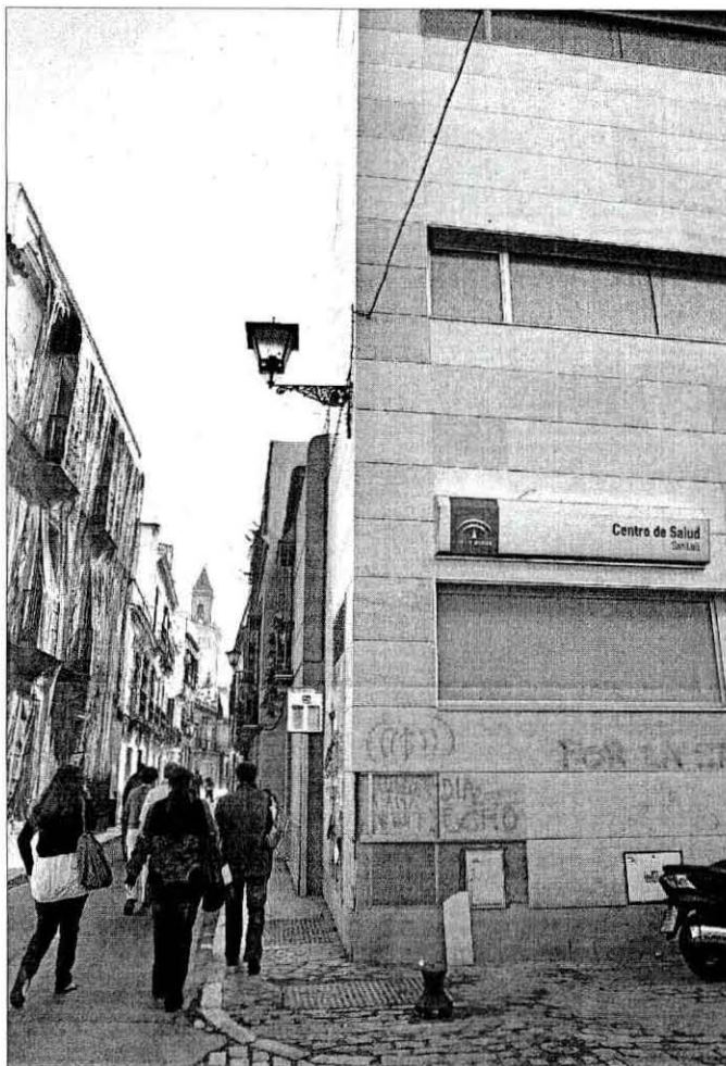
Centro de salud situado en la esquina de las calles San Luis e Inocentes. / CONCHITINA
