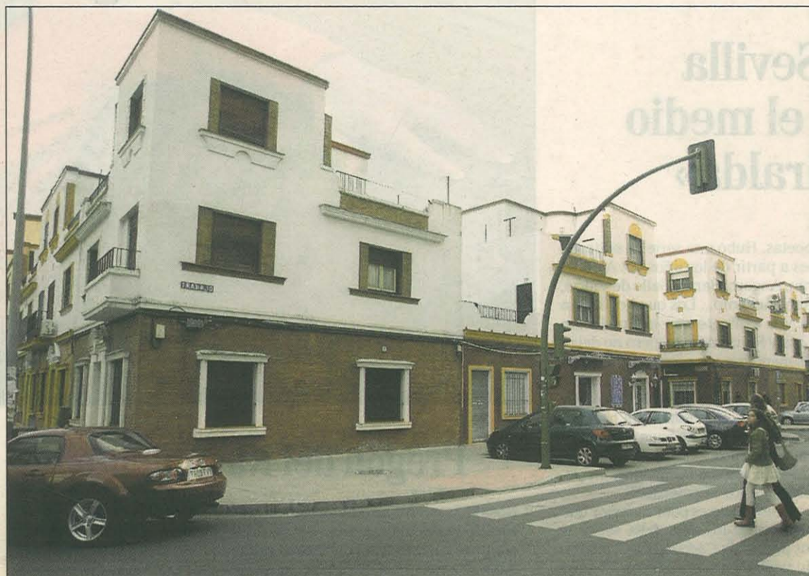
A la izquierda, la casa de esquina que será demolida y sustituida por otra de nueva construcción. / ESTHER LOBATO
