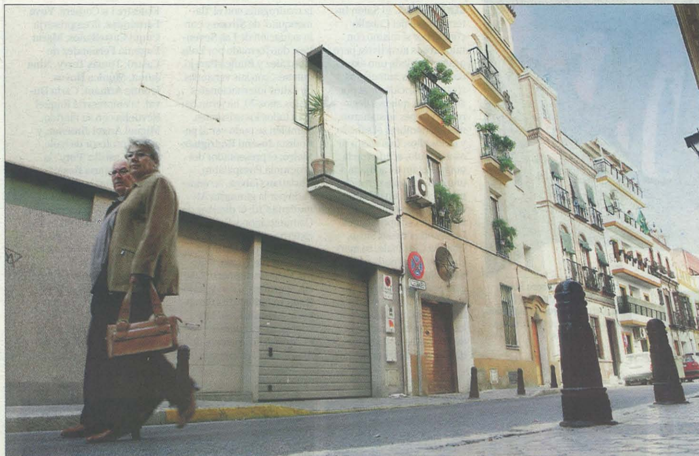
Fachada del inmueble ubicado en el número 25 de la calle Santa Ana, una de las 'aportaciones' de la arquitectura moderna en Sevilla. / CONCHITINA
