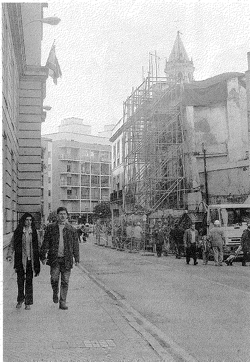
La calle Almirante Apodaca presentaba el martes este aspecto a consecuencia del derrumbe en uno de sus edificios históricos
