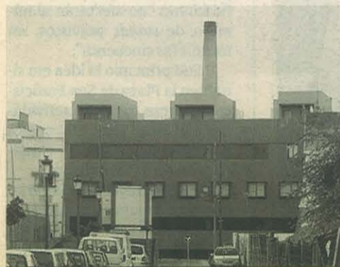
VIVIENDAS. Vista de la fachada.
