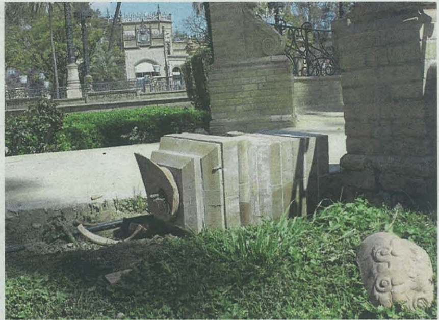
Detalle de los destrozos ocasionados por los vándalos
