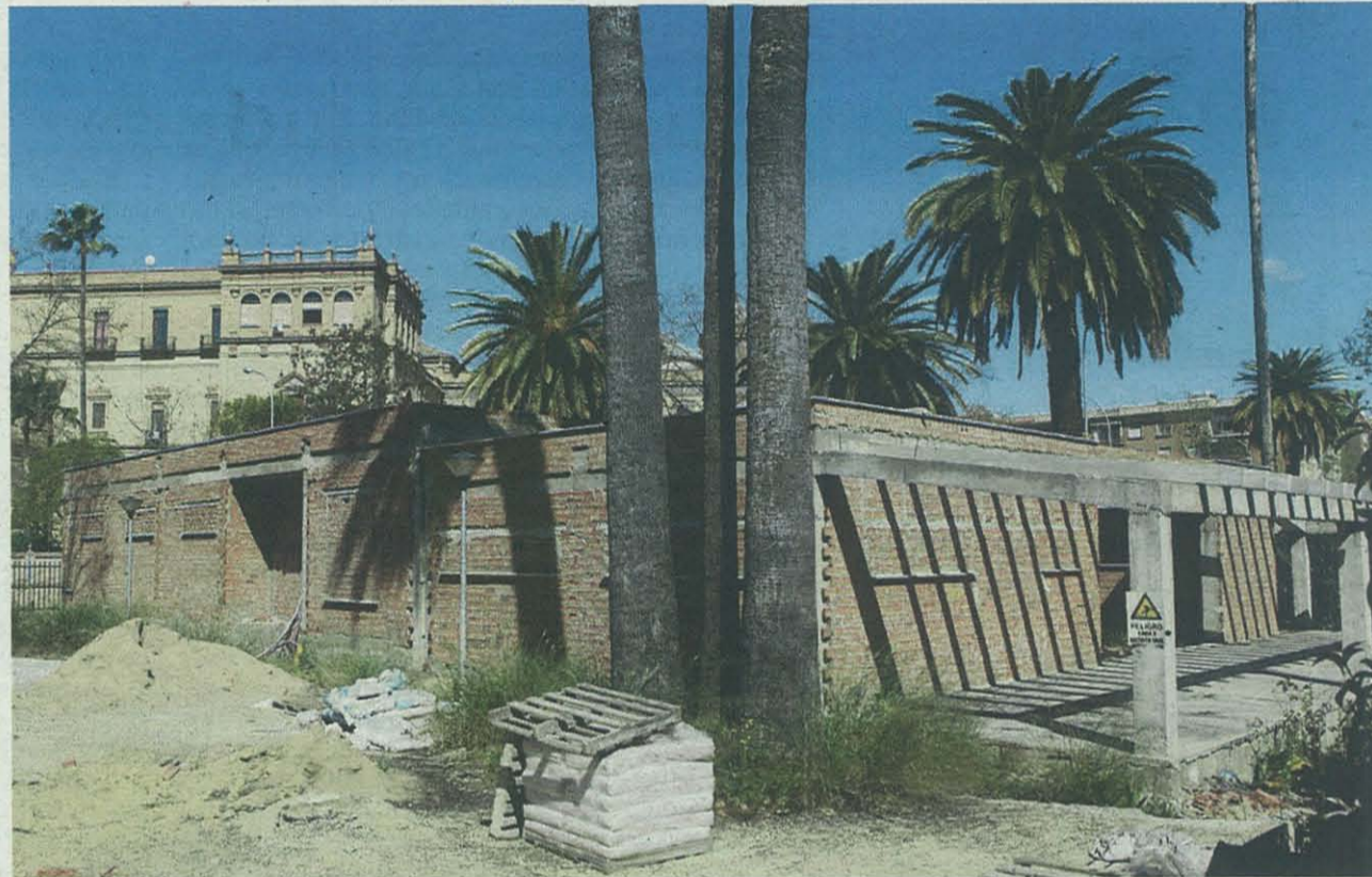
Estado actual del nuevo parque infantil de tráfico
