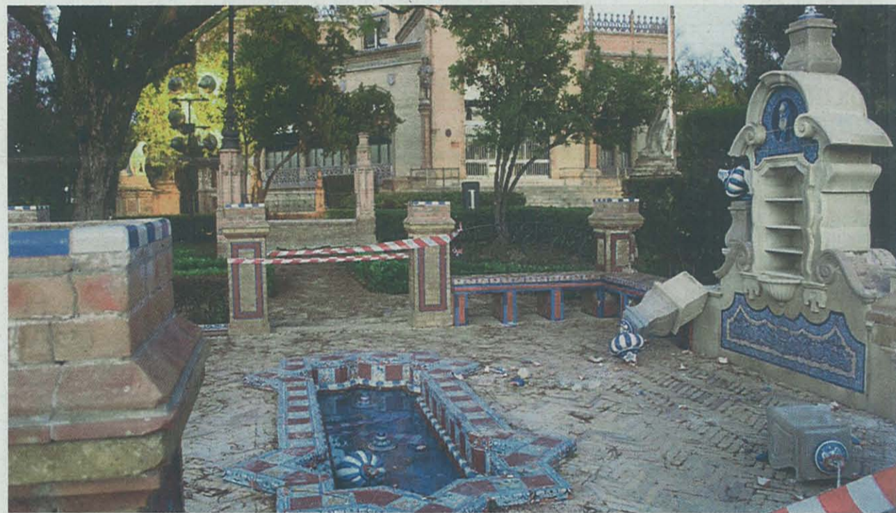
Varias pilastras de la glorieta Rodríguez Marín, arrancadas y tiradas sobre el suelo
