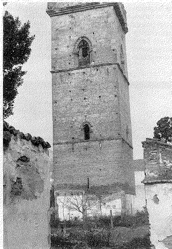
La Torre de Don Fadrique en una fotografía inédita de principios del siglo XX. Juan Talavera Heredia aún no había reformado este espacio; falta por excavar la base del monumento, y en la zona inferior quedan las huellas —muro encalado y mechinales reaprovechados— de las construcciones adosadas que allí hubo. Años más tarde, Talavera embelleció este rincón mediante una alberca donde se reflejaba la torre y distribuyó alrededor piezas de la colección arqueológica municipal.
